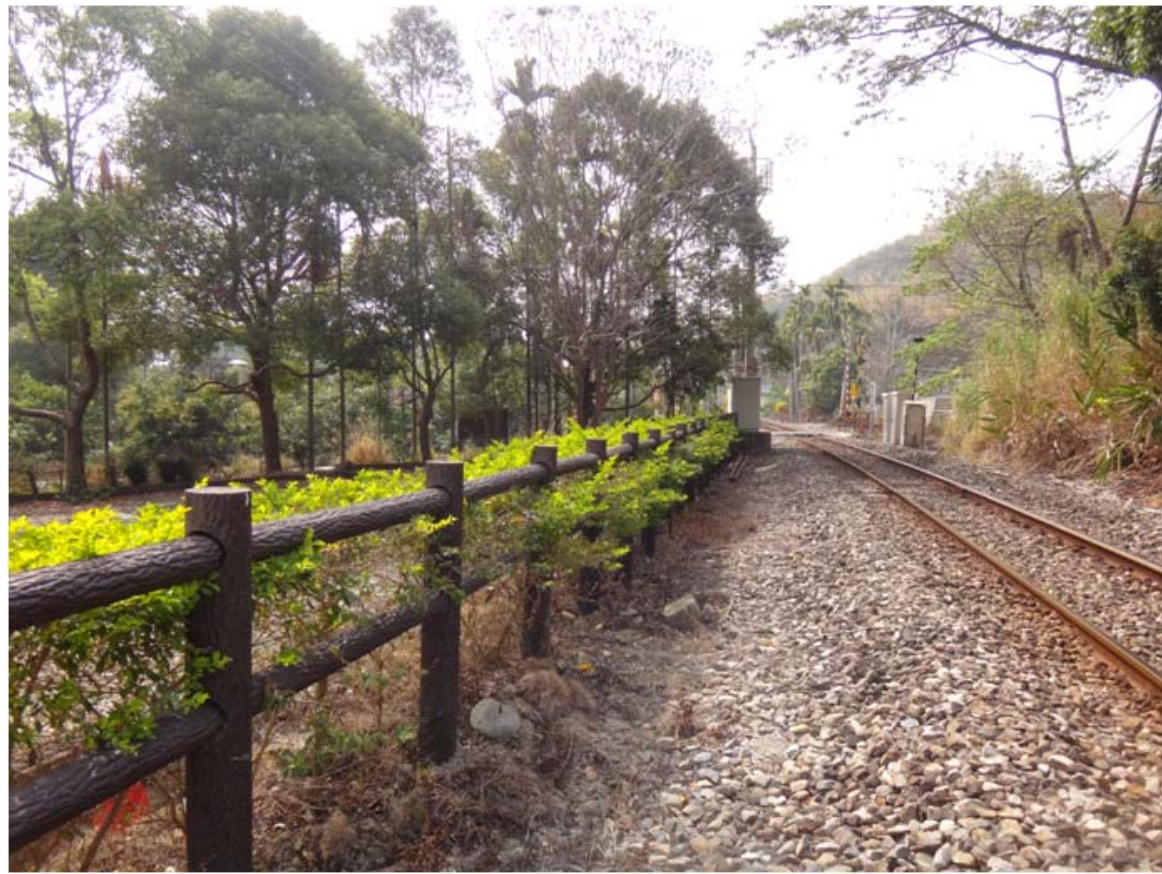
(B) 二木欄杆(立柱 \phi 13 橫木 \phi 8.5 )
